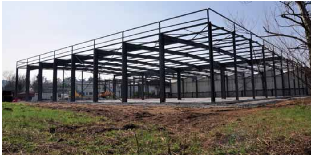
A Saint-Chamond, des travaux sont en cours pour agrandir l'atelier de 400 m 2 , soit une superficie de 4 500 m 2 sur les 6 500 m 2 abritant l'ensemble de l'activité serrage.
